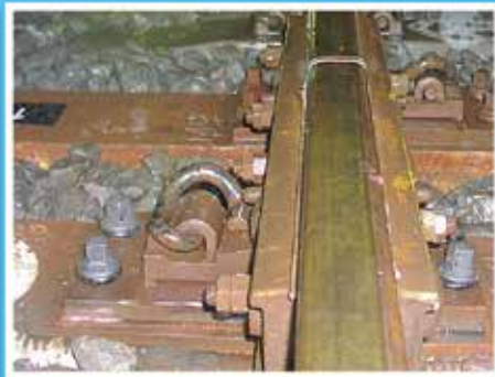
合成まくらぎ孔補修工法
