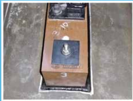
まくらぎ止め工法
