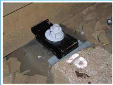
ネジ山再生工法
